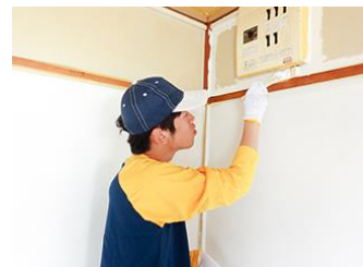
入居予定の空き部屋は、スタッフ指導のもと自らの手で改修します
