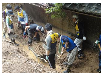
災害が発生した時は、現地に支援に向かいます
